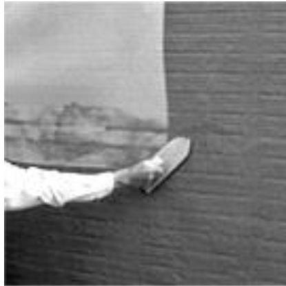
図 22 モルタル施工時のネット伏せ込み
