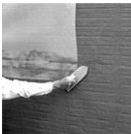
図 18 耐アルカリ性ガラス繊維ネットの伏せ込み
